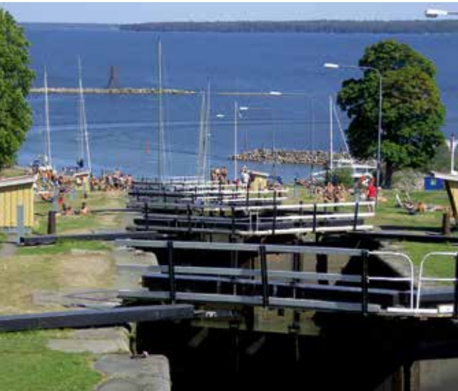
På bilden finns några av Bergs slussar i Göta kanal. Slussarna på bilden lyfter eller sänker båtarna 19 meter. I bakgrunden ses sjön Roxen på 33 m ö.h.
