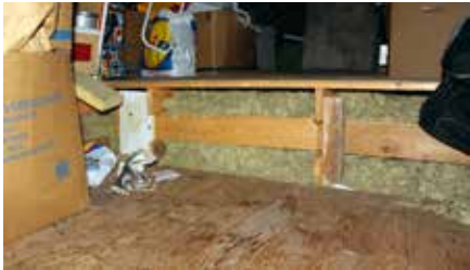
Isolering av vinden minskar värmeförlusten.
