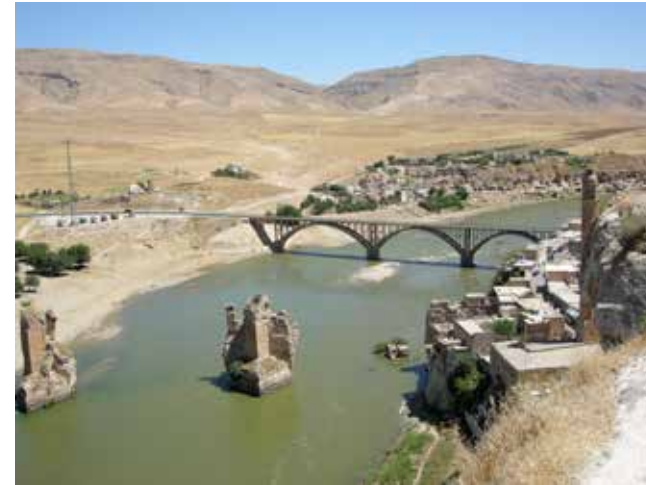
I förgrunden ses resterna av en gammal bro över floden Tigris, Hasankeyf, sydöstra Turkiet. Den byggdes 1116. Den nya bron finns i bakgrunden.
